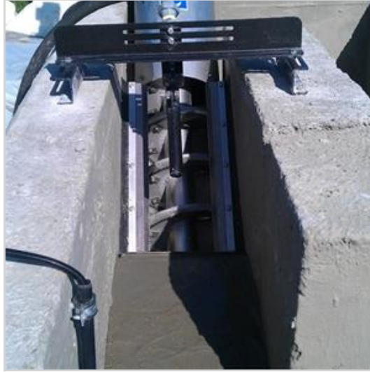
Operatörlerin İş Yükünün Büyük Bir Kısımını Yapan (Bifine) Otomatik İnce Izgara
