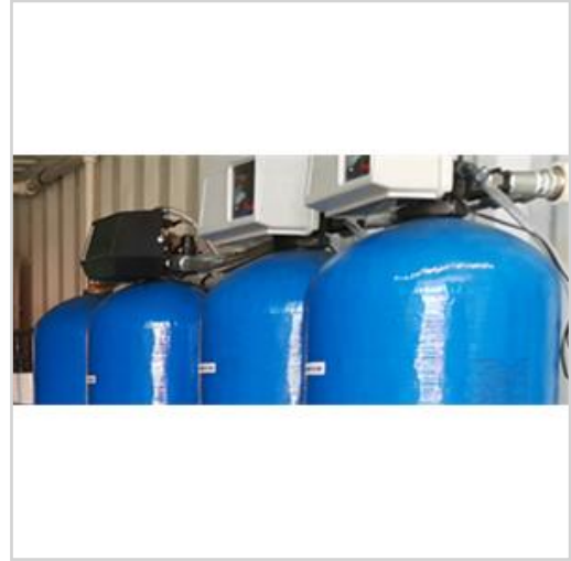
Suda Çözülmemiş Organik Kirliliklerin Arıtılmasında Kullanılan Aktif Karbon Filtrasyon Sistemi
