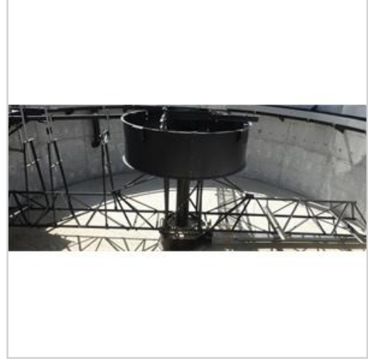
Aktif Çamuru Sıyırarak Sistemin Başına Gönderen Çamur Sıyrıcı
