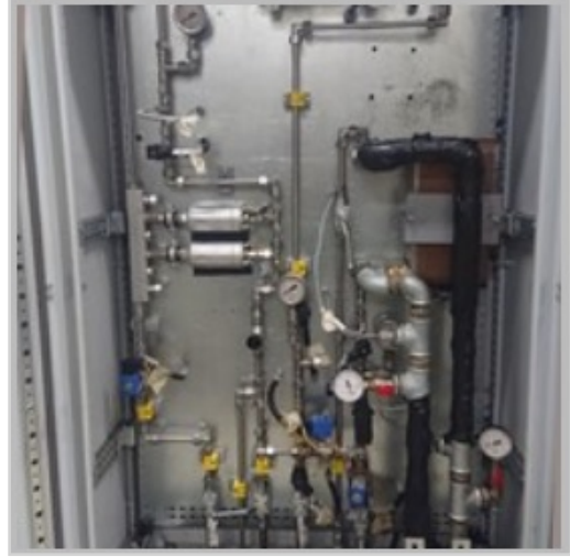
Yakıt Sıcaklığını Çevre Şartlarından Etkilenmeden Sabit Tutan Motor Yakıt Şartlandırma Sistemi
