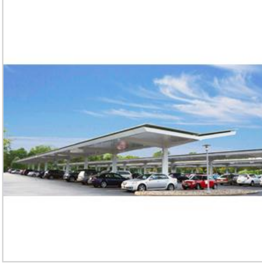
Otopark Alanı Güneş Enerji Sistemleri
