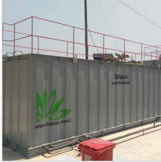
Su İçerisindeki İstenmeyen Maddeleri Ayırtmada Kullanılan (Bipak) Paket Atık su Arıtma Ünitesi
